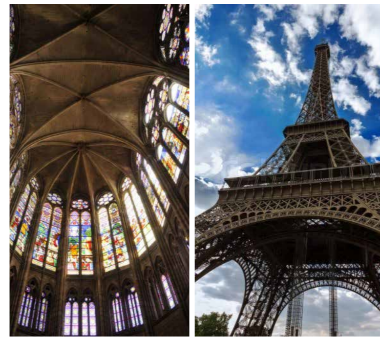
Görsel 2. (sol) Gotik bir katedralin kaburga tonoz üst örtüsü ve vitray pencere açıklıkları (Url 3) ile (sağ) Eiffel Kulesi'nin köprüyü çağrıştıran yatay-dik çizgisel demir parçaları ve ajurlu-havadar yapısı (Url 4) benzerliği
